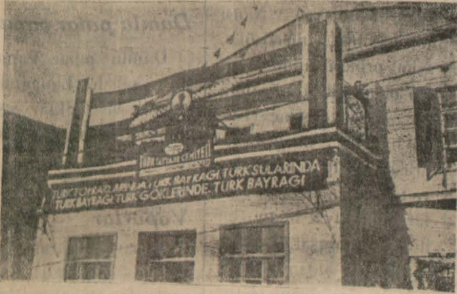
Mersin Tayyare Cemiyeti Binası
